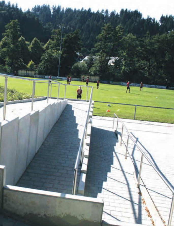
Eine rollstuhlgerechte Rampe ermöglicht den behindertengerechten Zugang zum Multifunktionsfeld und den Fitnessgeräten
